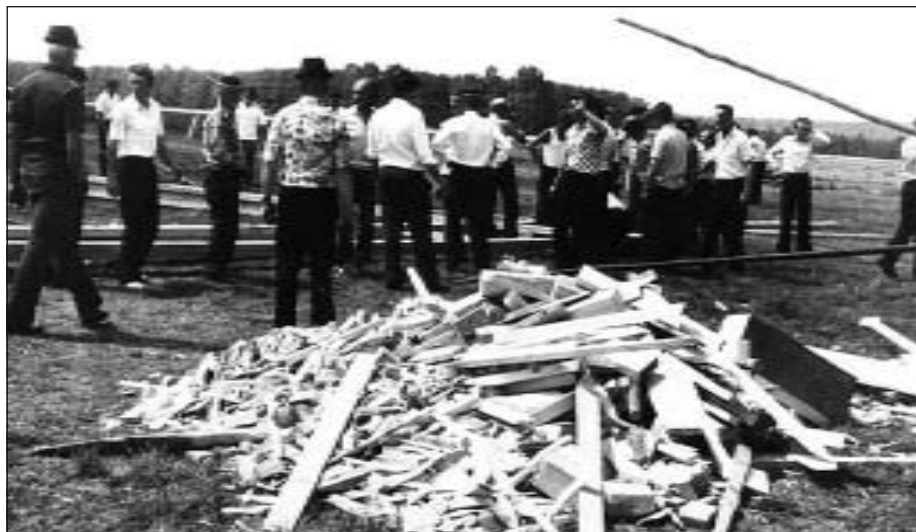
Odpady z budowy ołtarza i brygada cieśli (piąty od lewej – dyrektor PBK w Nowym Targu, inż. Andrzej Stopka), fot. Kazimierz Pajerski
